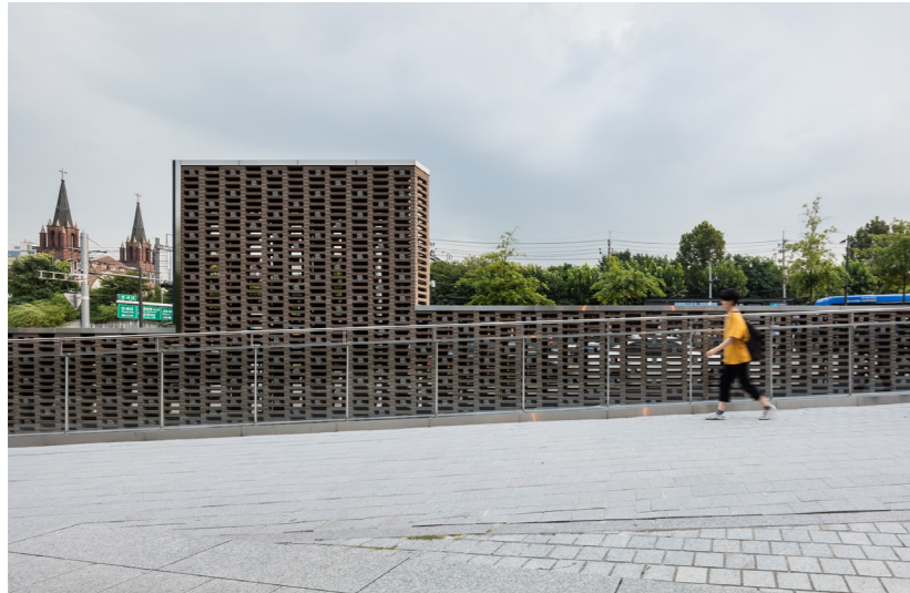
연대 앞 창작놀이센터 _지하보도 리모델링 공연, 전시, 카페 및 창업지원시설, 2017 / 서울시 창의상수상
